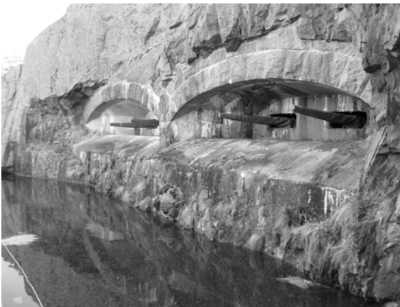
Bild 1. Götiska batteriet, sett från väster.
